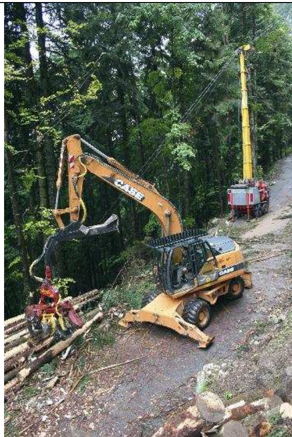
La pelle mécanique dotée d'une tête de bûcheronnage reprend les résineux à l'arrivée du câble, les façonne et les range en bordure de route.
